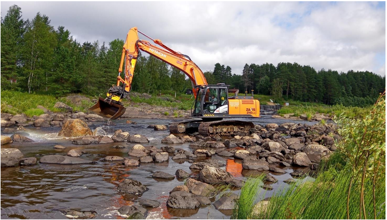
Kuva 10. Raasakkakosken pohjoisuoman uudelleen kiveämistä.
